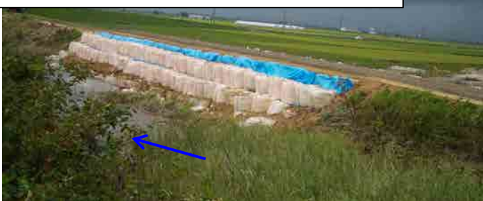
③ 応急仮締切 完了 8月23日
