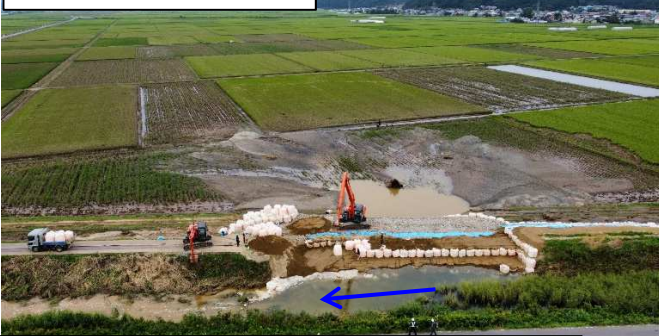
③ 応急仮締切 完了 8月23日
