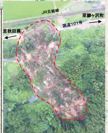
国道101号迂回路（深浦町黒崎地内）
